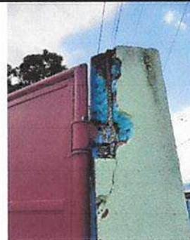
Foto 4: se necesita reparar las columnas que sostienen el porton
